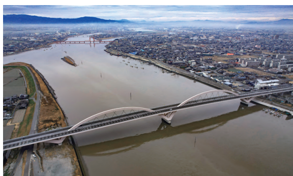
有明筑後川大橋(ドローン空撮)
