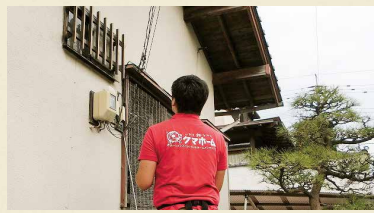
▲(株)クマホームの住宅診断の状況
