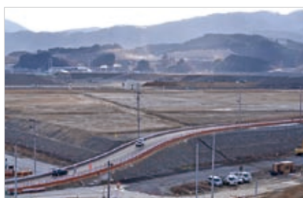
かさあげ工事
