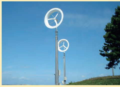
福岡市の百道浜に設置された風力発電『風レンズ風車』
