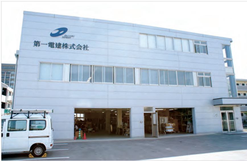
第一電建(株) 外観
