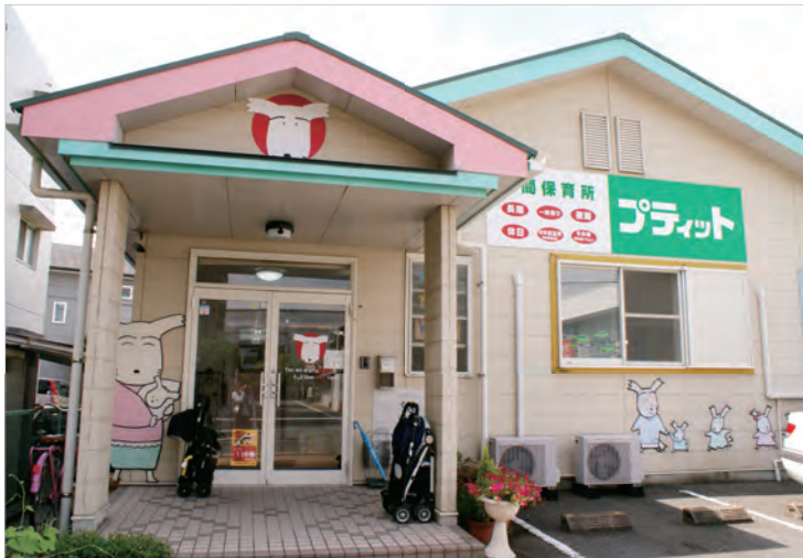
プレティット姪浜ルーム 外観
