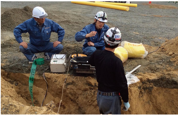
ガス配管工事の様子
