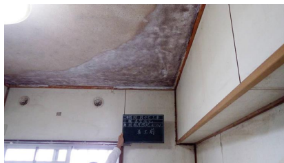
天井防カビ施工前
