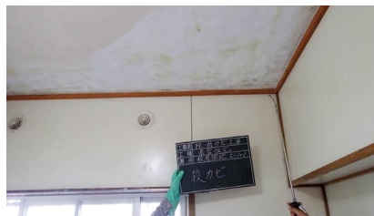
天井防カビ施工後
