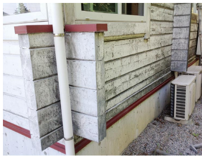
外壁防カビ施工前
