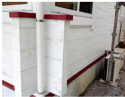
外壁防カビ施工後
