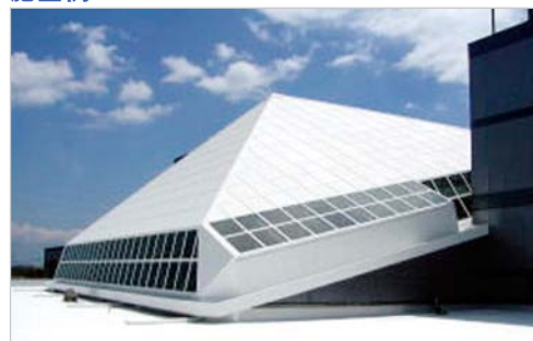
ガラス、シート防水にもガイナ塗装
