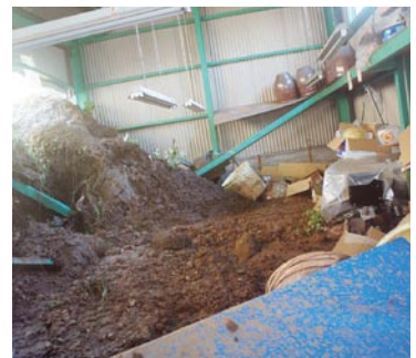
被害にあった八女地区の工場の様子
