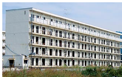
津波の高さはアパートの4階まで達した
