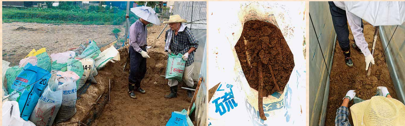
こんなに多くの土砂が搬出されました たくさんの小枝が混じっています 手作業で掻き出します
