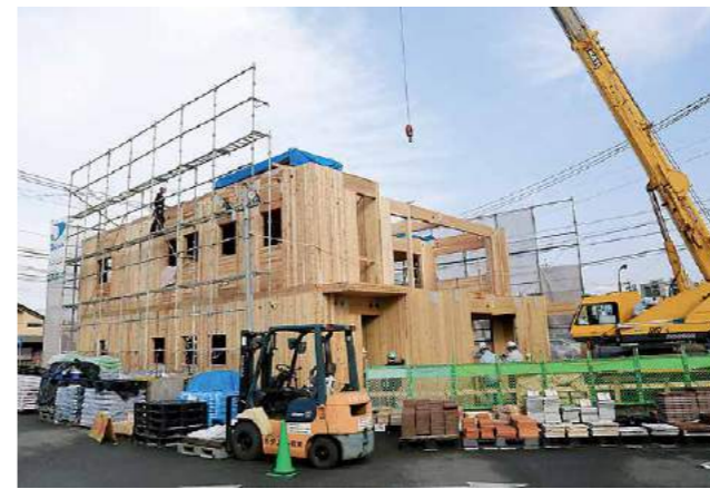
工事の様子(外観)
