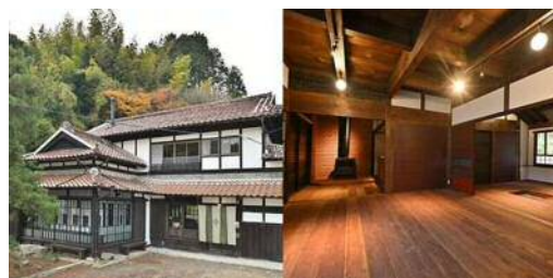
古民家体験施設 結（YUI）
