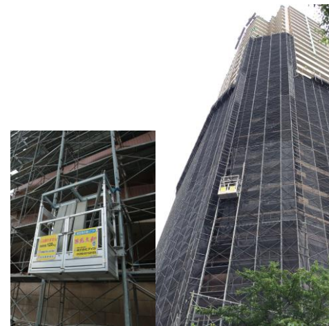
ビルの仮設足場を昇降する「猿鷲太助」
